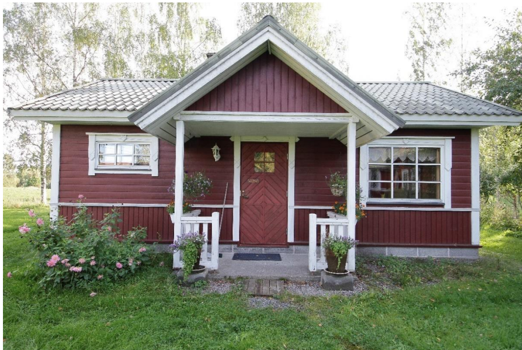
Kuva 78 1980-1990-luvuilla valmistunut saunarakennus vanhan pihapiirin eteläreunalla.
