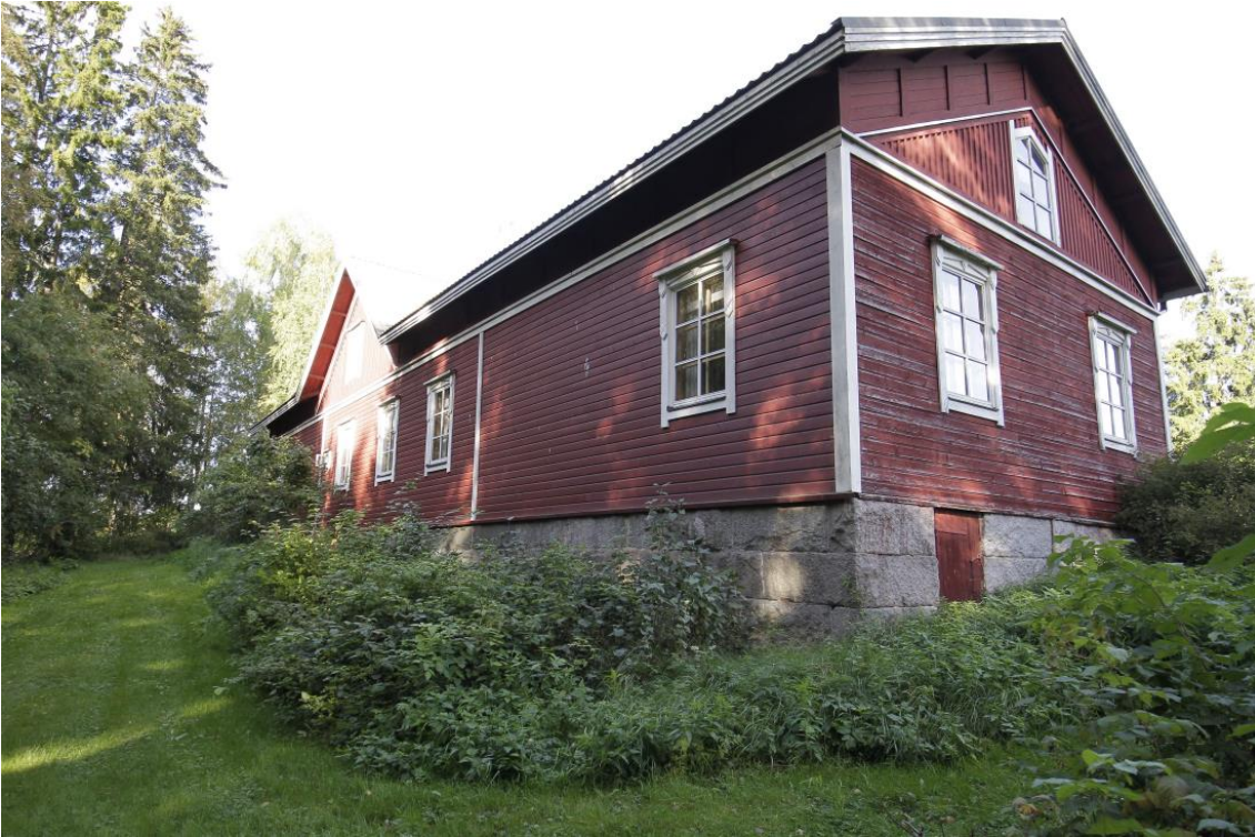
Kuva 70 Asuinrakennuksen länsi- ja eteläjulkisivut.
