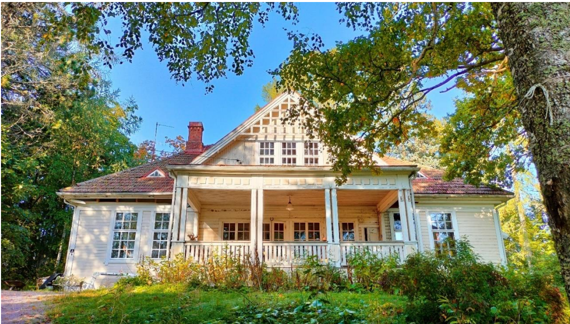
Kuva 27 Niemenkärjen päärakennuksen kaakkoisjulkisivu ja pääsisäänkäynti pihatien päästä kuvattuna.
