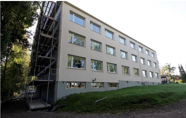
Kuva 120 Vanhainkodin luoteissiipi on julkisivusaneerattu vuonna 2023.
