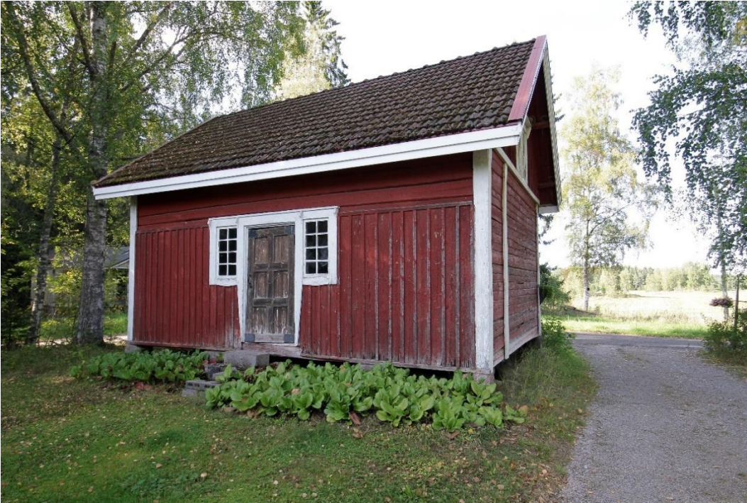
Kuva 72 Aittana tunnettu rakennus sijaitsee päärakennuksen edustalle johtavan pihatien ja Nurmintien risteyksessä. Aitan ovi ja ikkunat vaikuttavat olevan peräisin asuinrakennuksesta.
