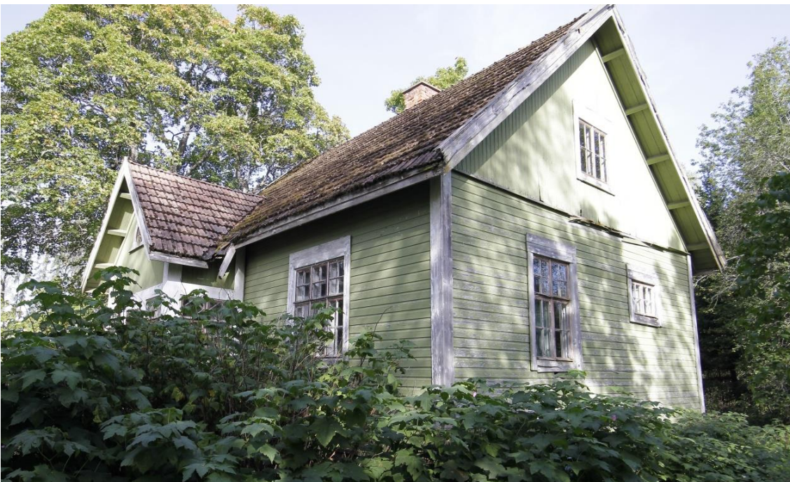
Kuva 93 Kovapään pienempi jugendvaikutteinen asuinrakennus vuodelta 1917 pihapiirin itälaidasta. Kuvassa rakennuksen länsi- ja eteläjulkisivut.
