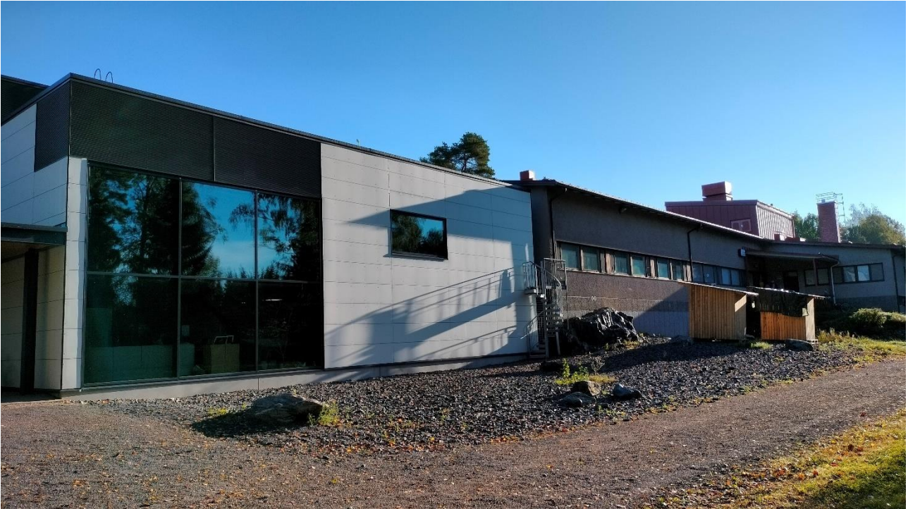
Kuva 130 Monitoimisalilaajennus ja koulun vanhaa osaa kuvattuna lännestä päin.
