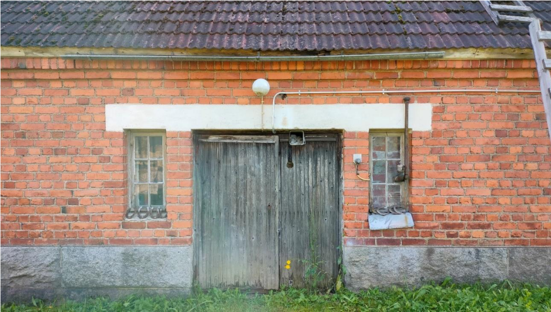
Kuva 109 Tiilinavetan sisäänkäynti pohjoisjulkisivulla.
