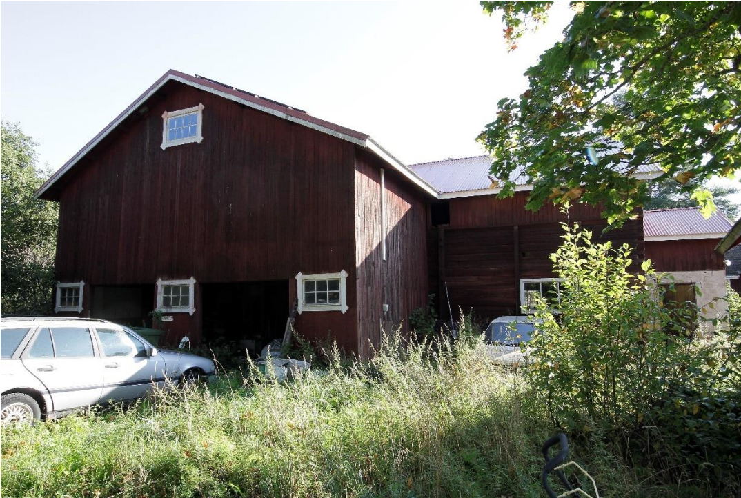
Kuva 44 1900-luvun alussa rakennettu navetta.
