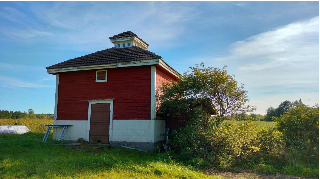
Kuva 95 Säterikattoinen vilja-aitta sijaitsee asuinpihan lounaiskulmassa peltoauekan reunalla.
