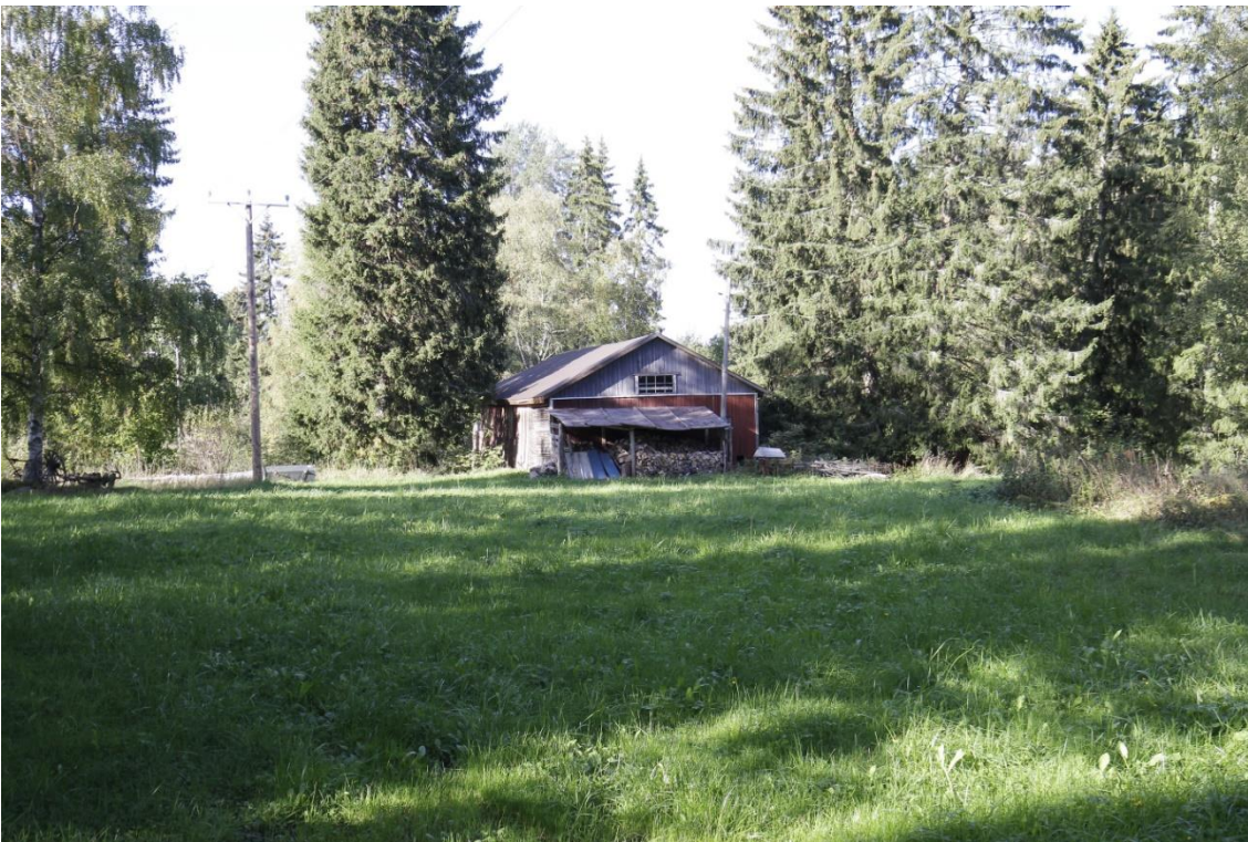
Kuva 56 Talousrakennus Rumootantien lähellä.
