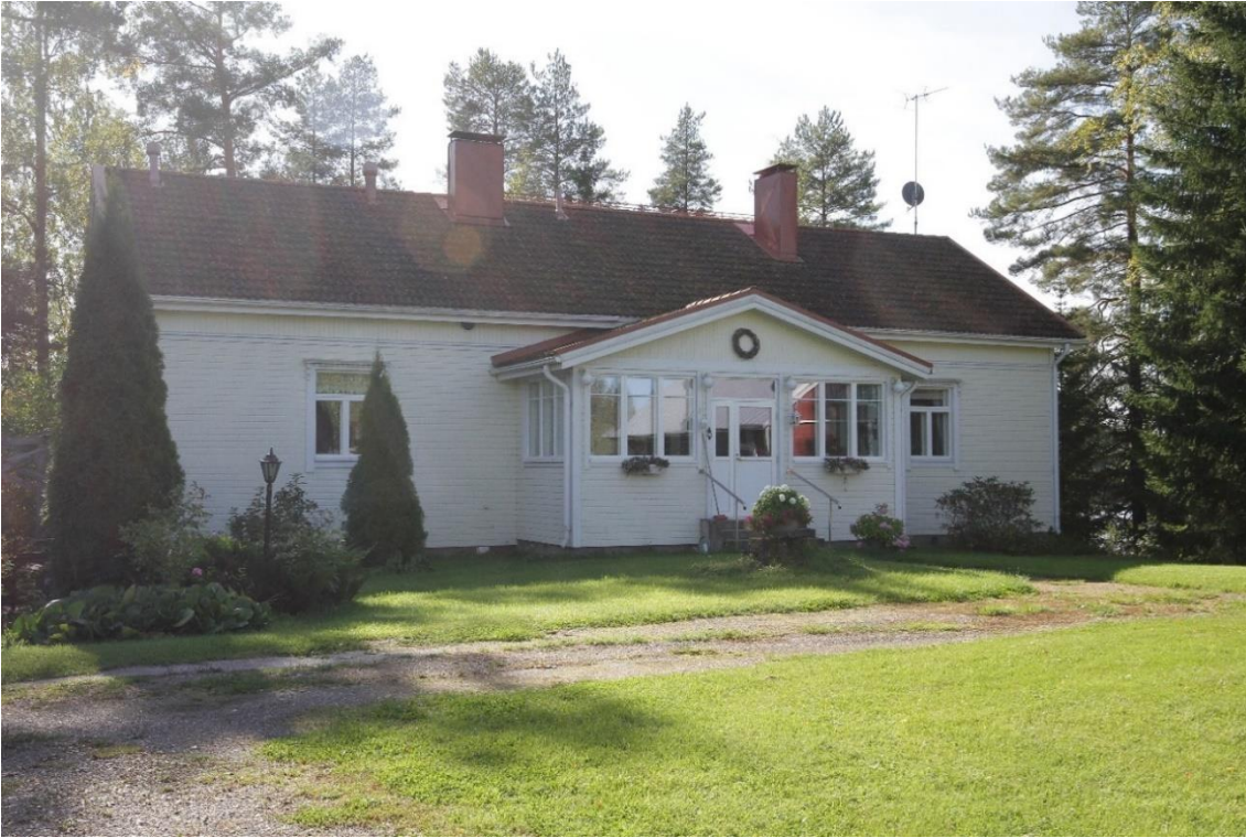
Kuva 58 Rumootta-Mikkolan päärakennuksen pohjoisjulkisivu.
