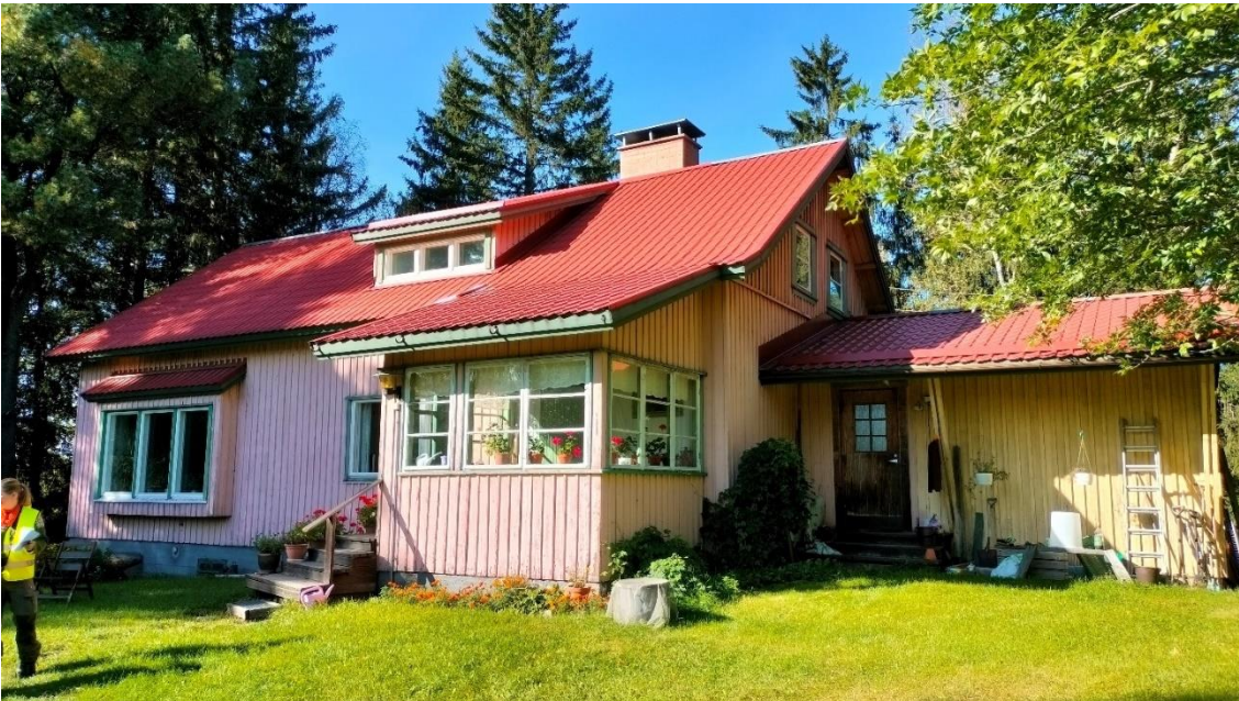
Kuva 132 Kantapartolantie 95:n, eli varsinaisen Partolan päärakennus kaakosta kuvattuna. Päärakennuksen itäsiipi on maalattu vaaleankeltaiseksi, mutta muu rakennus on ulkoveriltään vaaleanpunainen. Talo on luultavasti ollut alkujaan noppamainen jälleenrakennuskauden talo, jota on laajennettu länteen 1950-luvulla ja itään ns. elintasosiivellä 1970-luvulla.
