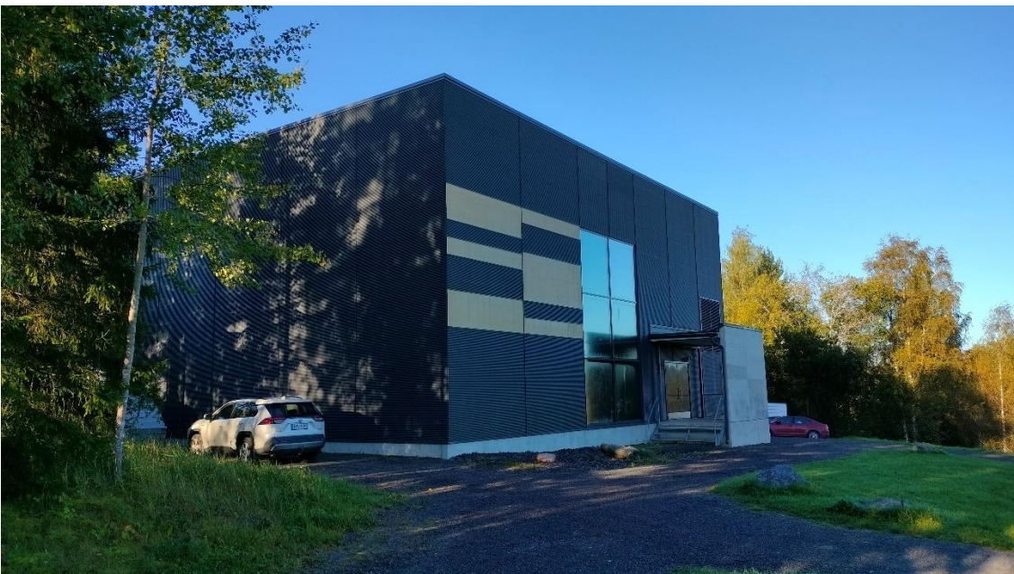
Kuva 129 Koulun länsipäättyyn rakennettu monitoimisalilin laajennus.
