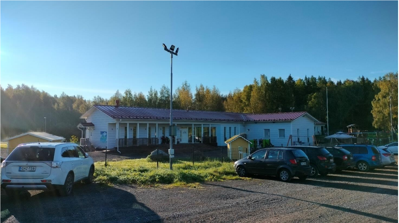
Kuva 128 Päiväkoti Pikkupursi kuvattuna luoteesta päin.
