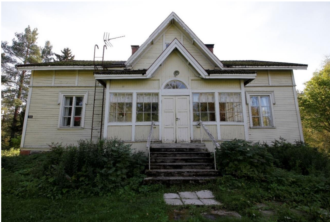
Kuva 49 Pihlajamäen päärakennuksen koillisjulkisivu.
