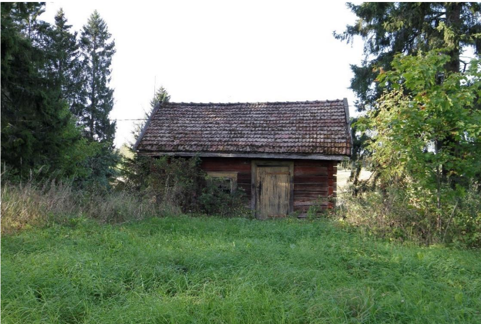
Kuva 73 Hirsirakenteinen sauna Nurmintien pohjoispuolella, kauempana pihapiiristä.
