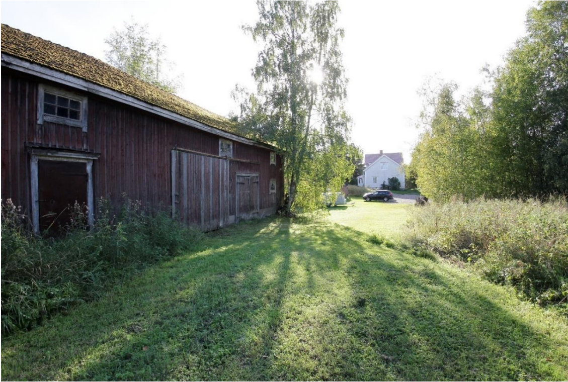
Kuva 105 Näkymä talousrakennuksen edustalta kohti päärakennusta. Kuvassa näkyy talousrakennuksen pohjoisjulkisivu ja päärakennuksen itäpäätä.
