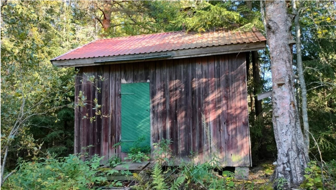
Kuva 139 Pihapiirin itäpuolella on pieni 1900-luvun puolivälin tai lopun talousrakennus.
